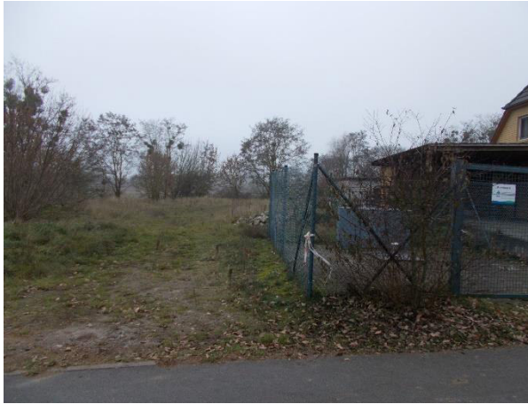
Abb. 4: Schmutzwasserpumpwerk Liepe auf Biotop Nr. 2
