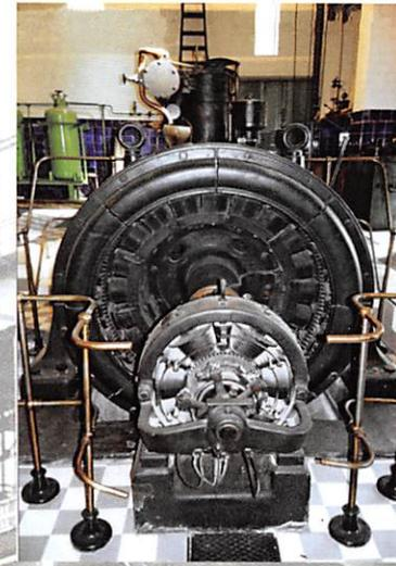
Das Kraftwerk ist von der Leistung her so bemessen, dass auch ein voller Hebewerksbetrieb bei Stromausfall möglich ist. Die Anlage besteht aus drei Maschinensätzen mit je einem kompressorlosen 4-Zylinder MWM Vorkammerdieselmotor mit 150 PS Leistung bei 300 Umdrehungen in der Minute.
