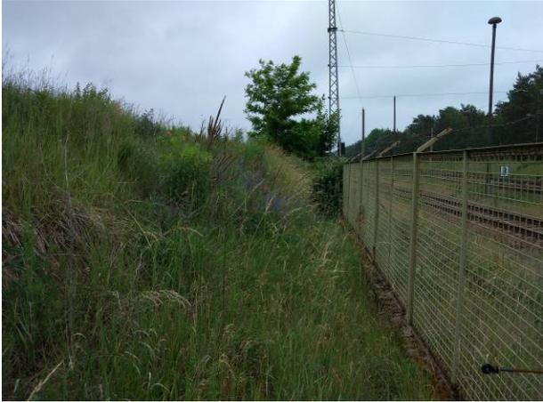
Abb. 8: Fehlender Hangfußbereich innerhalb des bestehenden Zauns und Mauerabsatzes im Süden. Der Zaun steht noch innerhalb des Grundstücks (19.06.2020)
