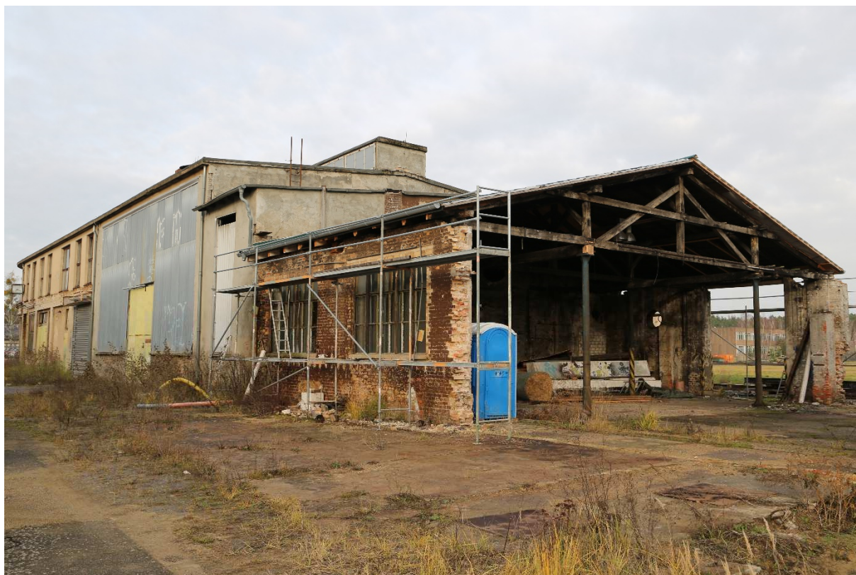
Abb. 7: Umzubauendes Gebäude B.
