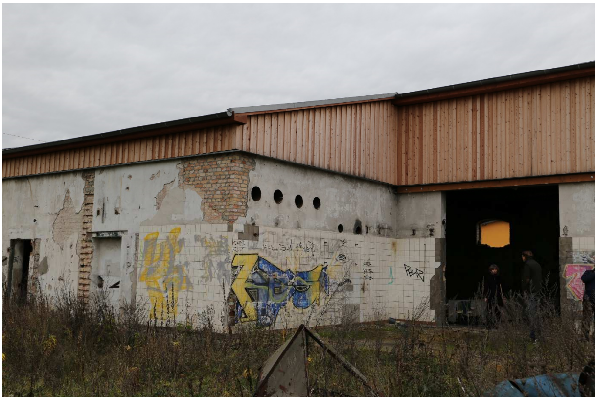
Abb. 16: Holzverkleidung am bereits im Umbau befindlichen Gebäude A, durch Einflüge für Fledermäuse nutzbar zu machen.
