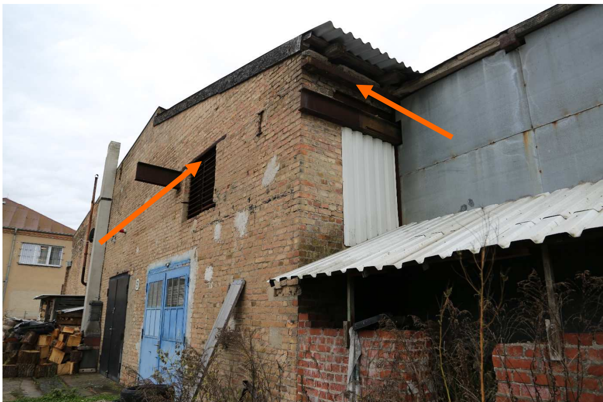
Abb. 5: Schaffung von Einflügen für Rauchschwalben an der Ostseite von Gebäude D.
