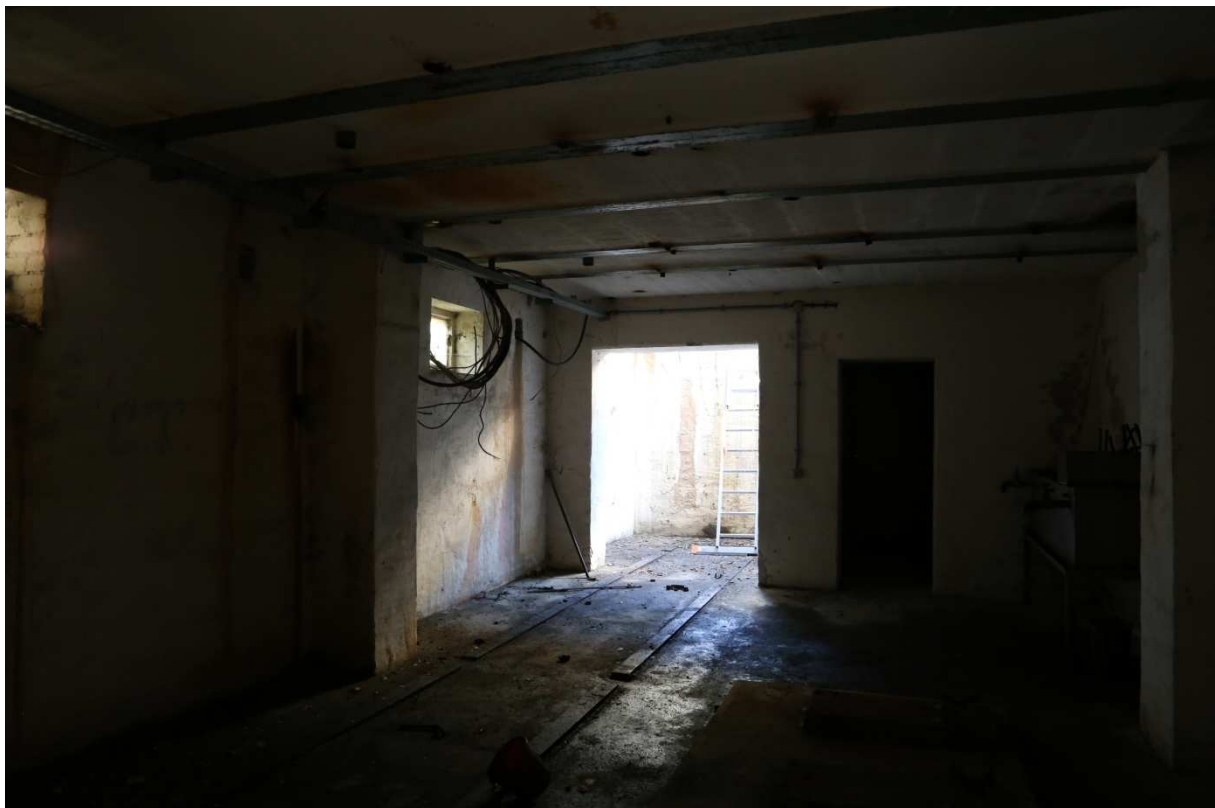
Abb. 20: Turmkeller (Gebäude C).
