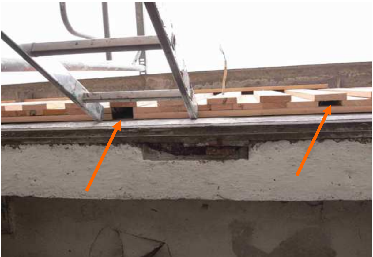
Abb. 2: Am unteren Rand der Holzverschalung werden Schlupflöcher ausgesägt, die den Fledermäusen Zugang zu den Hohlräumen hinter den Holzlatten verschaffen. (Quelle: NABU Kreisverband Rügen).
