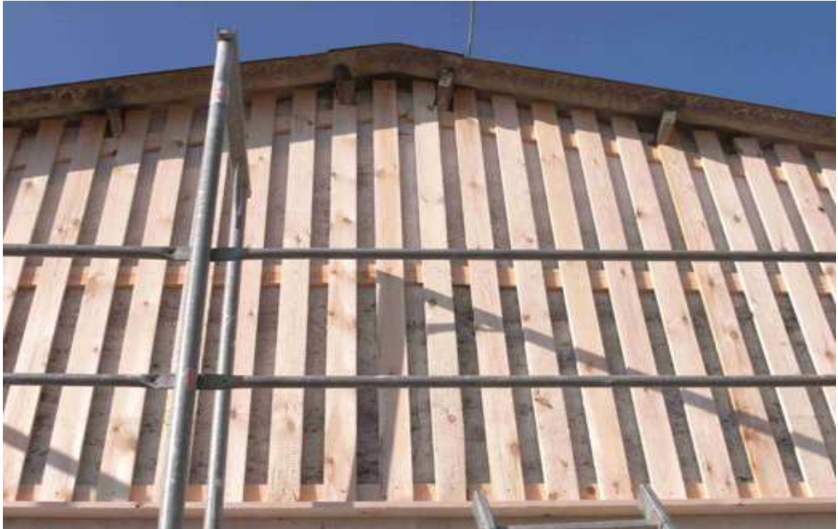
Abb. 1: Hinter den Holzlatten bleibt ein Hohlraum, in dem sich die Fledermäuse verstecken können. Die Holzlatten sind ungehobelt – sehr gute Bedingungen für Fledermäuse, die sich an den rauen Strukturen gut festkrallen können (Quelle: NABU Kreisverband Rügen).
