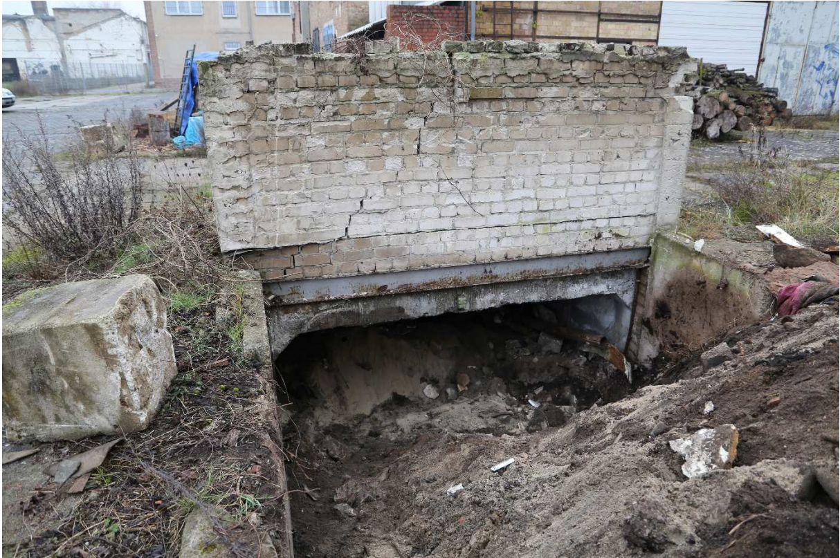
Abb. 17: Freigelegter Leitungsschacht, als Fledermauswinterquartier umzugestalten.
