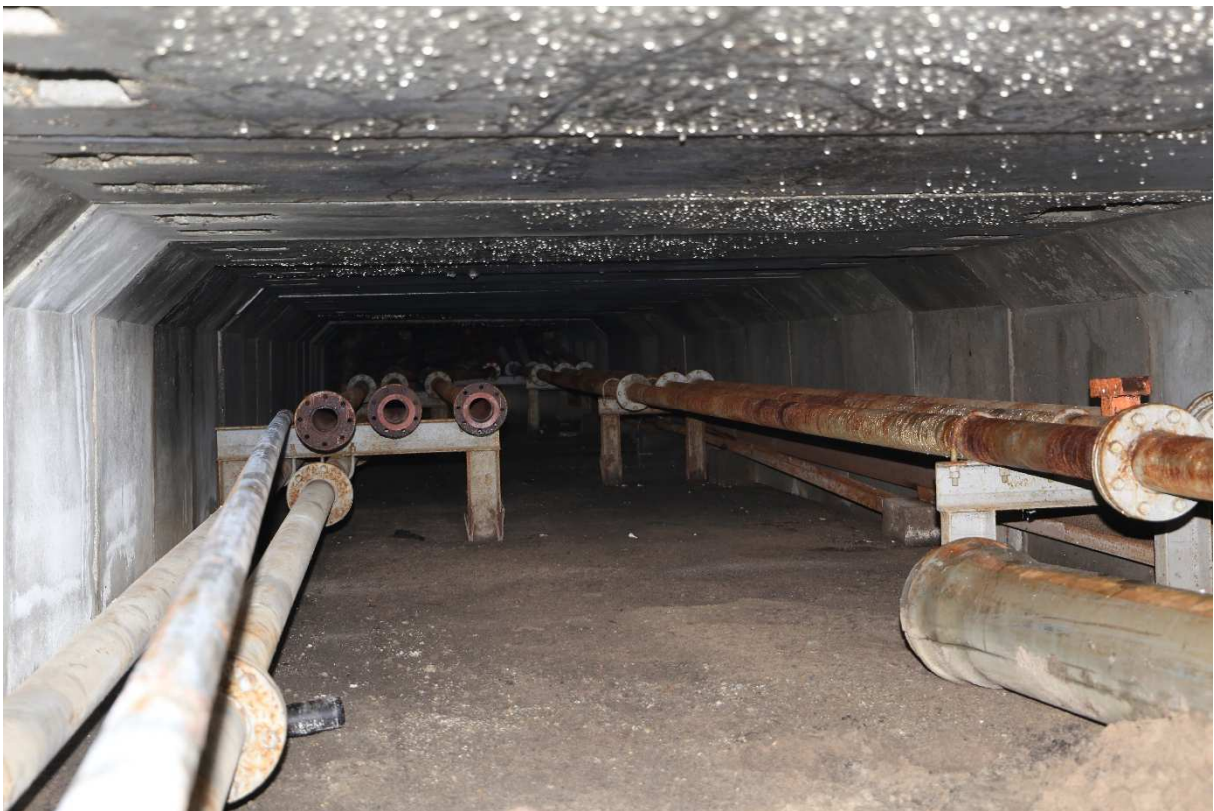
Abb. 18: Innenansicht des o.g. Leitungsschachts, mit Hangstrukturen (Winkler-Kammerlochsteine) für Fledermäuse aufzuwerten.
