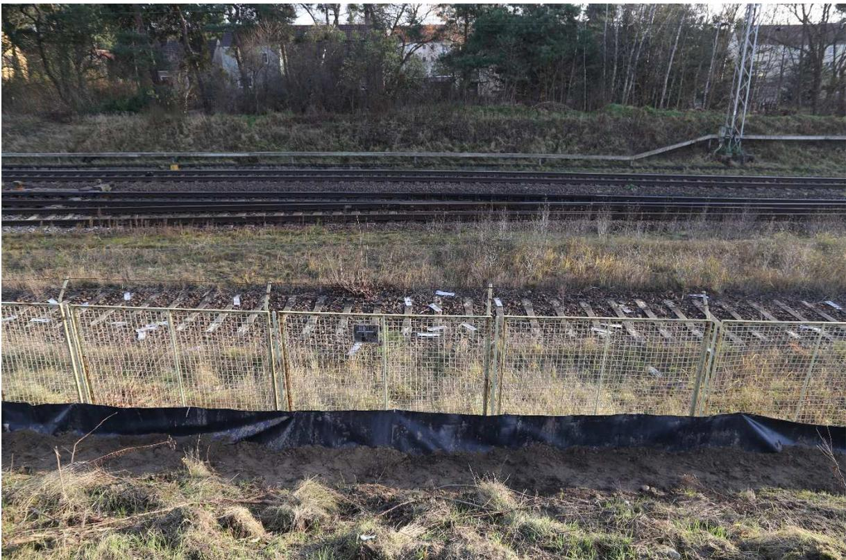
Abb. 24: Zur Vermeidung der Rückwanderung von Reptilien aus den Nachbarflächen der Bahn ist der Schutzzaun für die Bauzeit durchgängig funktionstüchtig zu halten.
