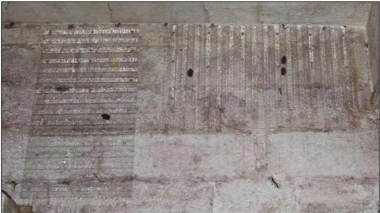
Abb. 3: Beispiel einer horizontal und einer vertikal an die Wand geschraubte Trapezlichtplatte. Die horizontale Trapezlichtplatte wurde an die Decke angeschlagen, um Zugluft in den Spalten der Trapezlichtplatte zu verringern. In der vertikalen Trapezlichtplatte befindet sich eine und in der horizontalen befinden sich drei überwinternde Fledermäuse (Abb. Matthias Götttsche)
