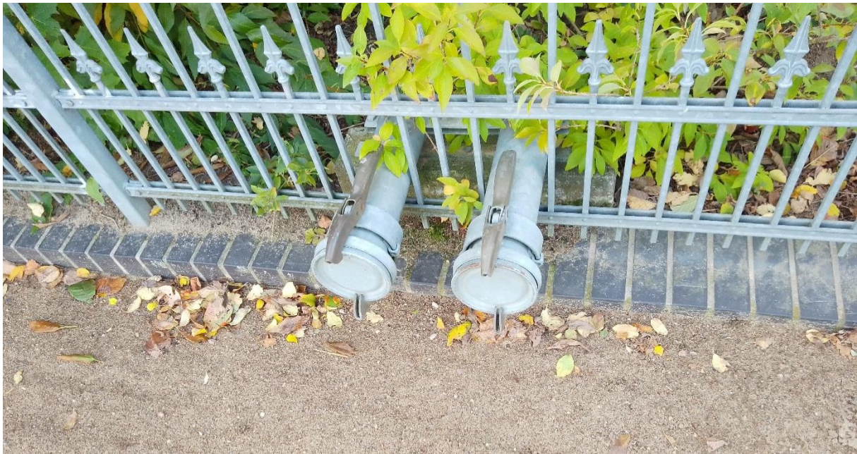
Abbildung 27: Sammelgruben-Entsorgungssystem in Lunow, Quelle: Ortsbegehung vom 27.09.2024
