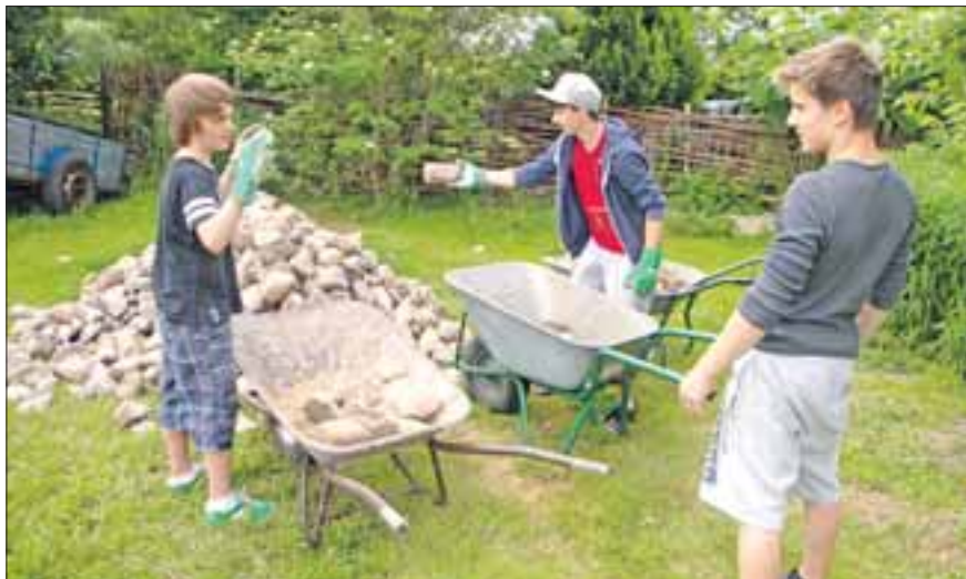
Bennet, Max und Benjamin als tatkräftige Helfer beim Ausbau des alten Fußbodens zur Instandsetzung der neuen Kinder- und Jugendwerkstatt
