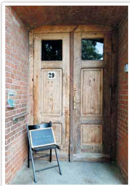
Die Haustür vor der Überarbeitung
