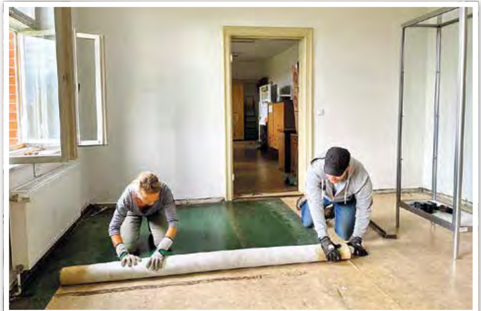
Bei einem Gemeinschaftseinsatz wird der alte Bodenbelag entfernt
