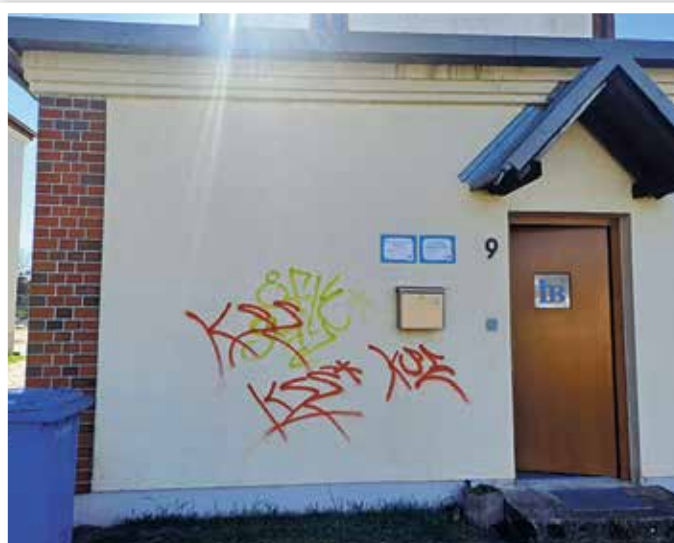
Die Büro-Fassade vorher
