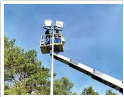
Hier die Firma Sportslight, Hauptstraße 31, 51766 Engelskirchen bei der Demontage der alten HQI Lampen und der Neumontage der LED Strahler. Es wurde Mast für Mast gearbeitet, so dass immer eine Demontage und eine Montage je Mast erfolgte.
