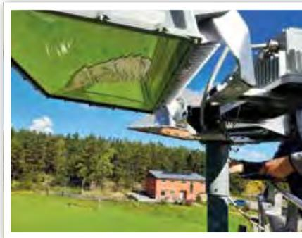
Montage und grobe Ausrichtung der Strahler am Tag. Die Feinjustierung erfolgt dann in der Nacht. In diesem Zusammenhang wurde die alte Mastverkabelung ausgetauscht und auch die alten Vorschaltgeräte entfernt.
